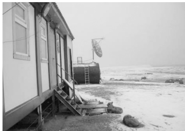
Установка системы спутниковой связи СС «VSAT» на МГ-2 Визе
